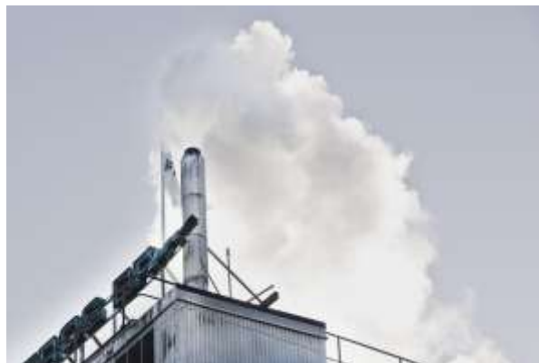
Ånga från scrubbern vid CTMP-linjen vid Rottneros Bruk.
