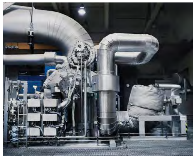
Genom ångturbinen för elproduktion i Vallvik producerar bruket en stor del av sitt elbehov. Turbinen genererar även intäkter i form av "gröna elcertifikat".
