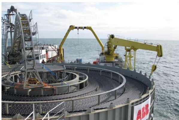
En av Vallviks specialprodukter är massa som används för isolering av avancerad starkströmskabel. Här läggs en undervattenkabel ut från ett speciellt kabelutläggningsfartyg.
