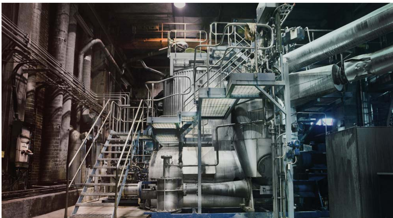
Utrustning för Basing av flis vid CTMP-linjen i Rottneros Bruk. Cirka 25 procent av den råvara koncernen köper är i form av färdig flis.
